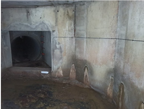
Figura 30. Sensor detector sobreiximent del pou 1 pou 1
