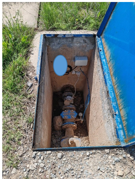
Figura 25. Imatges d'una arqueta amb un cabalímetre ubicada a les afores
