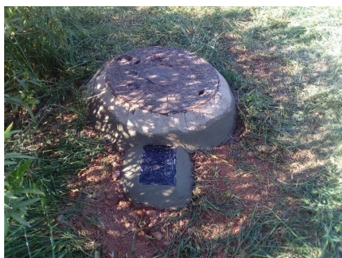
Figura 27. Pou de registre 1 al exterior
